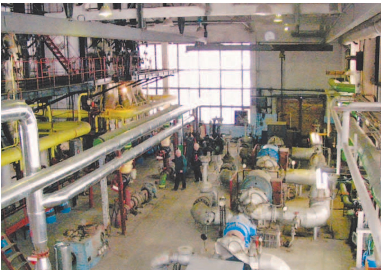
Ремонт оборудования котельной
